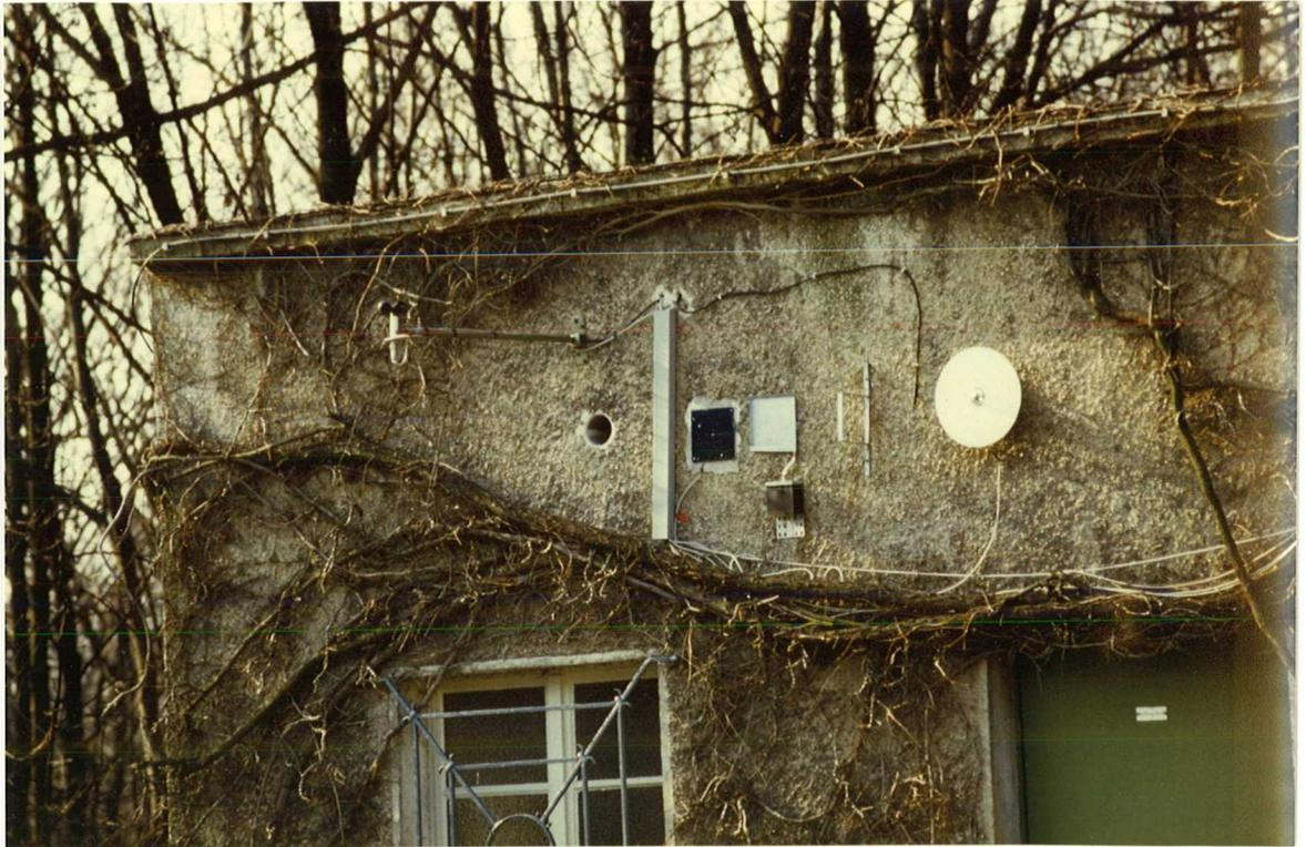
Bild 5 Meßeinrichtung zur Erfassung von Mikroklima-Parametern an allen begrünten und unbegrünten Fassadenbereichen der untersuchten Objekte, hier beispielhaft dargestellt am unbegrünten Fassadenbereich des Meßobjektes Essen-Margarethenhöhe. Sie besteht aus (von rechts nach links):
