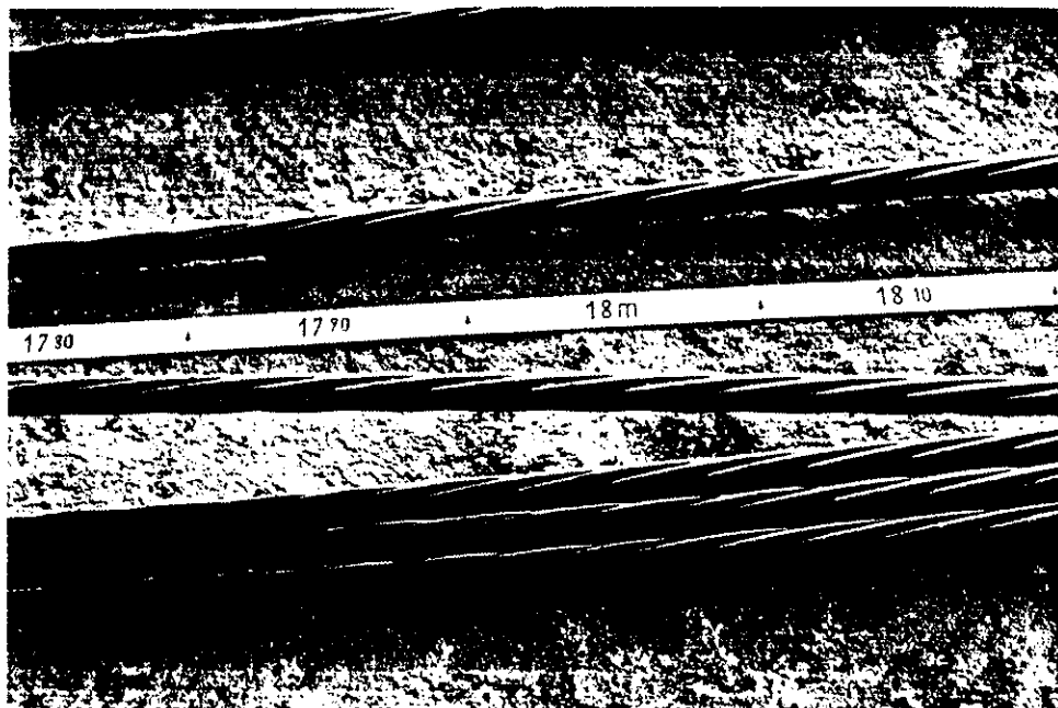
Abb. 20: Korrosionsverhalten der Litzen in der Mitte des Versuchsbalkens
