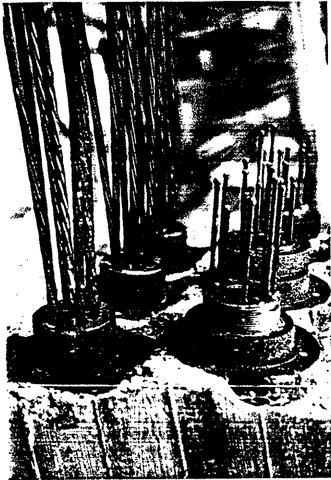
Abb. 19: Korrosionsverhalten der Spannstähle an den Enden des Versuchsbalkens
