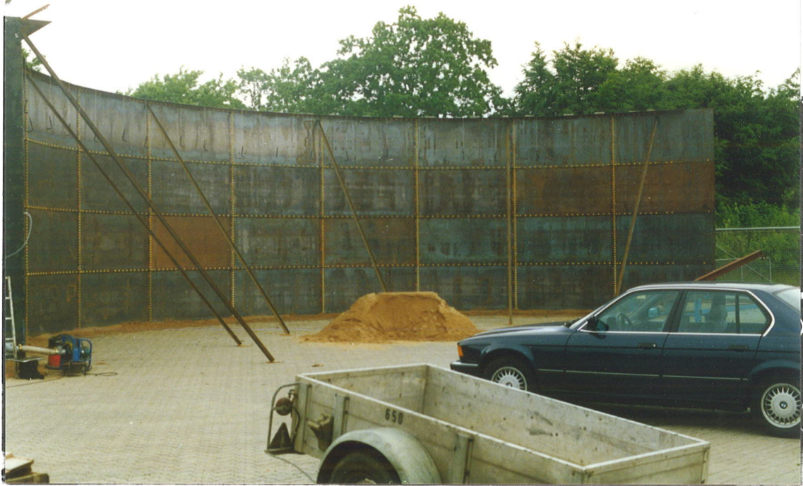
Bild 6.5: Feste Wand mit Stützkonstruktion
