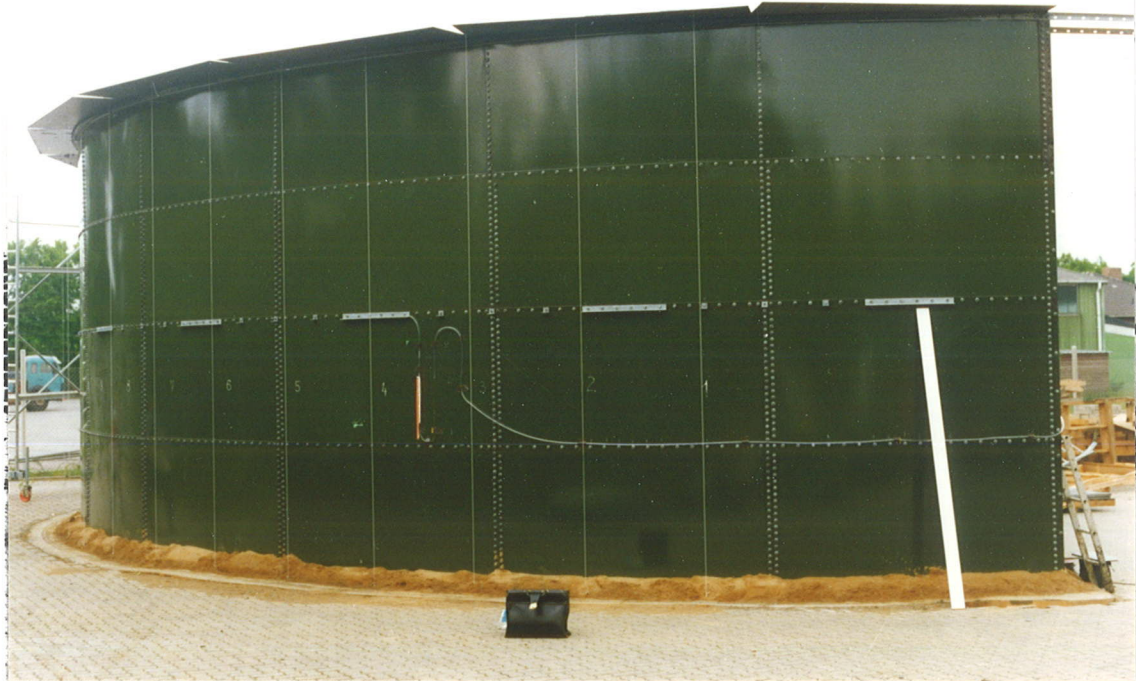
Bild 6.3: Behälter ohne Ringversteifung (emailierter Stahl)
