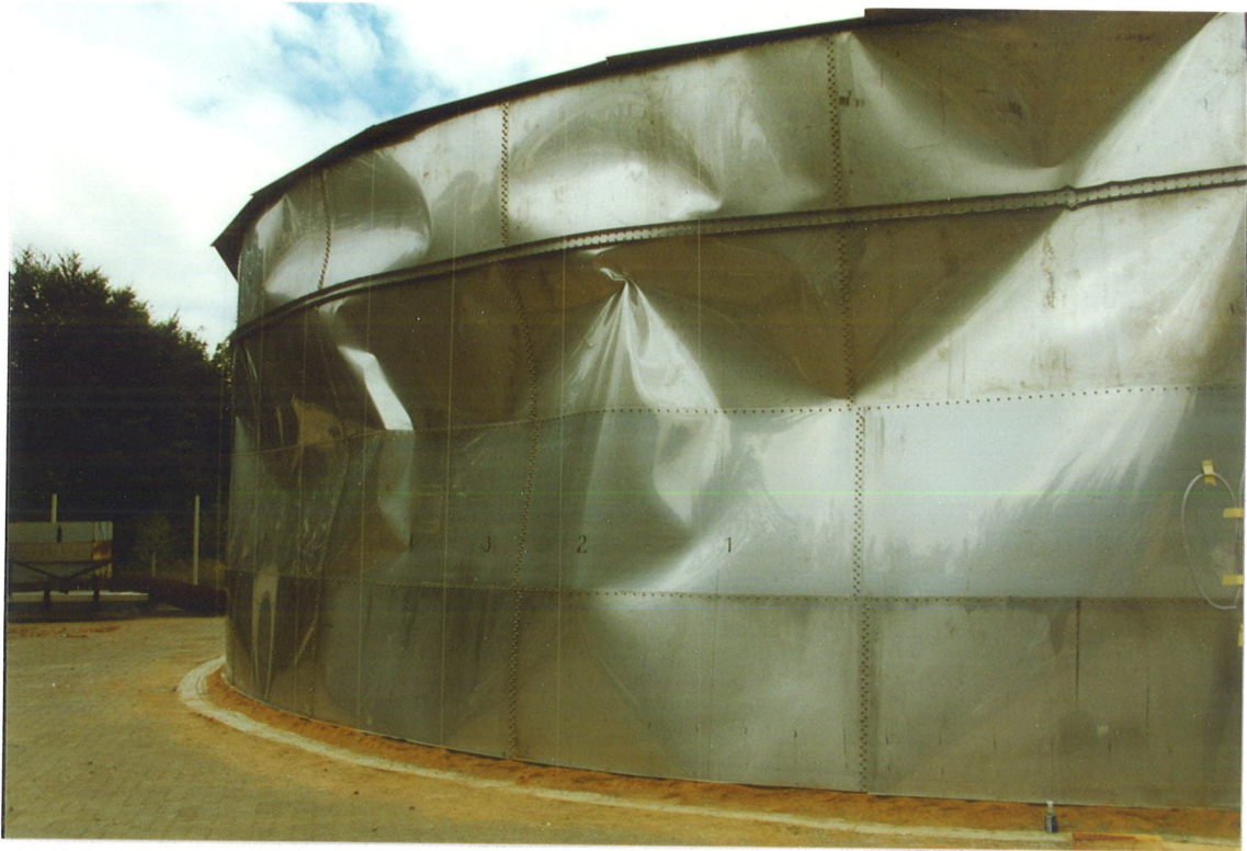
Bild 7.12: Beulbild bei einem Unterdruck von 75 mm WS (Behälter mit 1 Ringversteifung)
