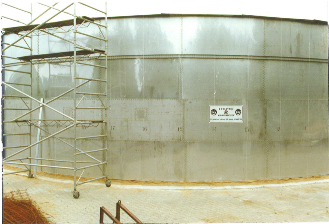
Bild 7.9: Behälter mit 1 Ringversteifung (V2A-Stahl)
