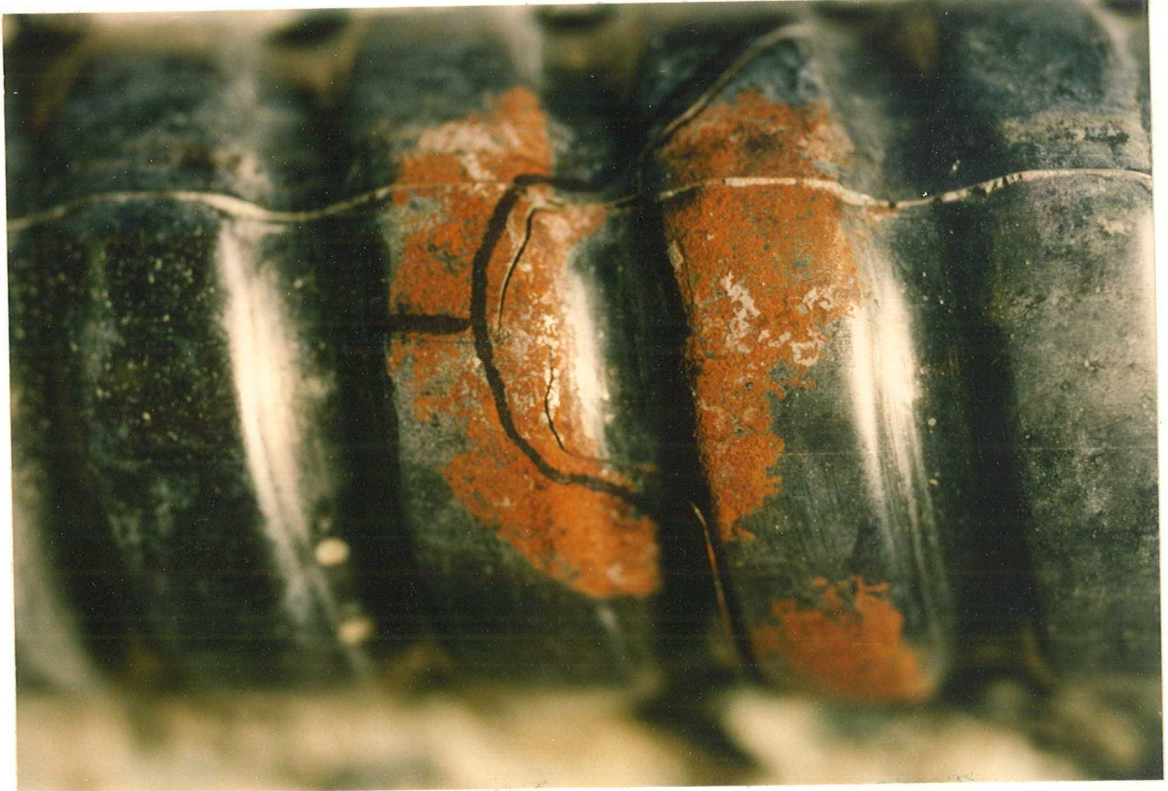
Korrosionsprodukte an der Hüllrohroberfläche
