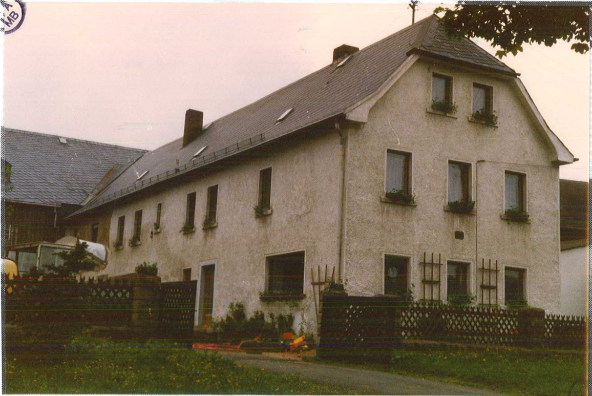
Bild 22: Standort A, Haus Nr. 11/12: Ansicht der Südost- und Nordostseite
