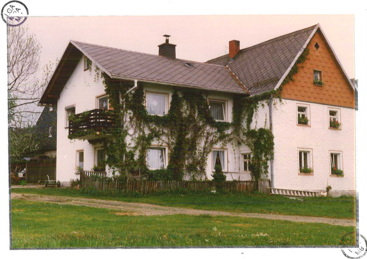
Bild 25: Standort A: Haus Nr. 16: Ansicht der Südwestseite
