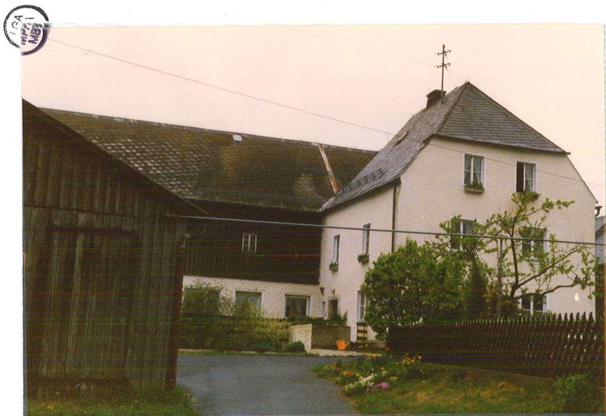
Bild 23: Standort A, Haus Nr. 13: Ansicht der Nordost- und Südostseite
