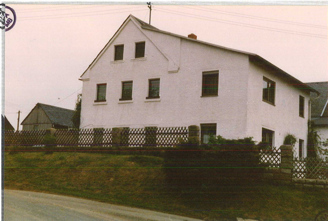
Bild 18: Standort A, Haus Nr. 04: Ansicht der Nordwestseite
