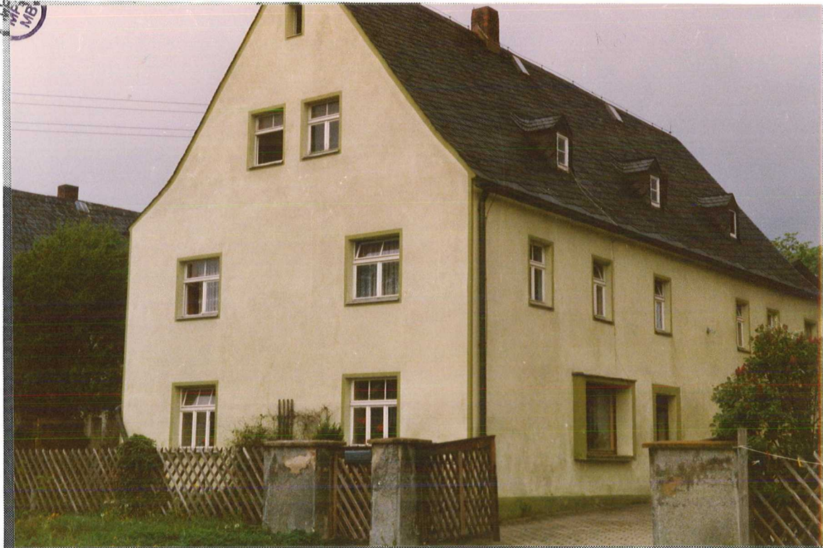
Bild 24: Standort A, Haus Nr. 15: Ansicht der Südost- und Nordostseite
