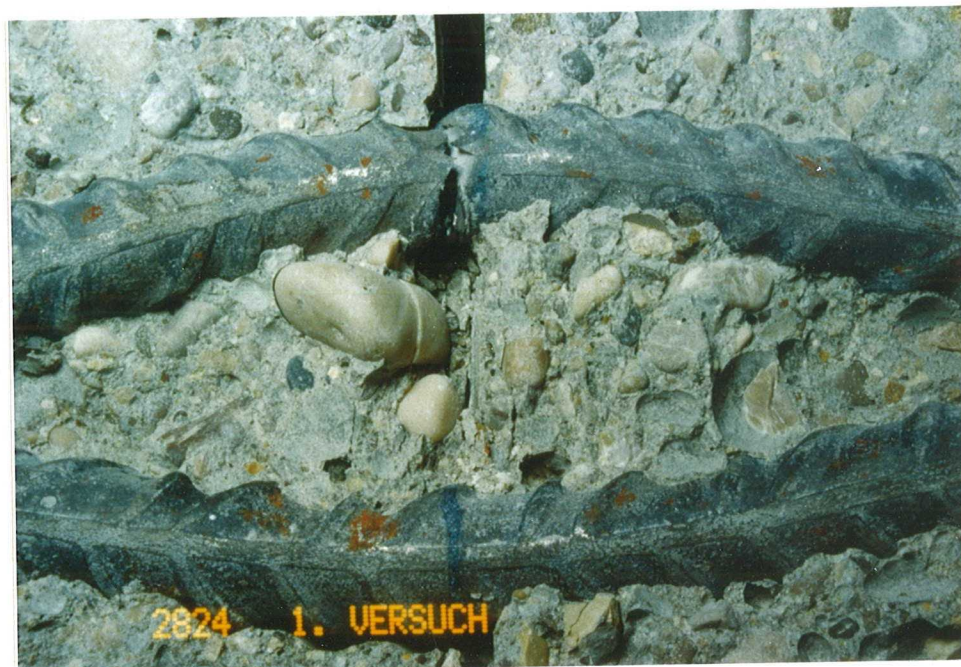
Photo 8: 2. Entwicklungsschritt Dauerschwingbruch an einem der eingelegten Betonstabstähle
