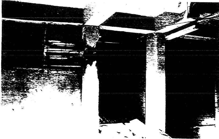
Bild 1.1: San Salvador Erdbeben am 10. Okt. 1986, Vergleich des Verhaltens einer Stütze mit und ohne Mauerwerksbrüstung
