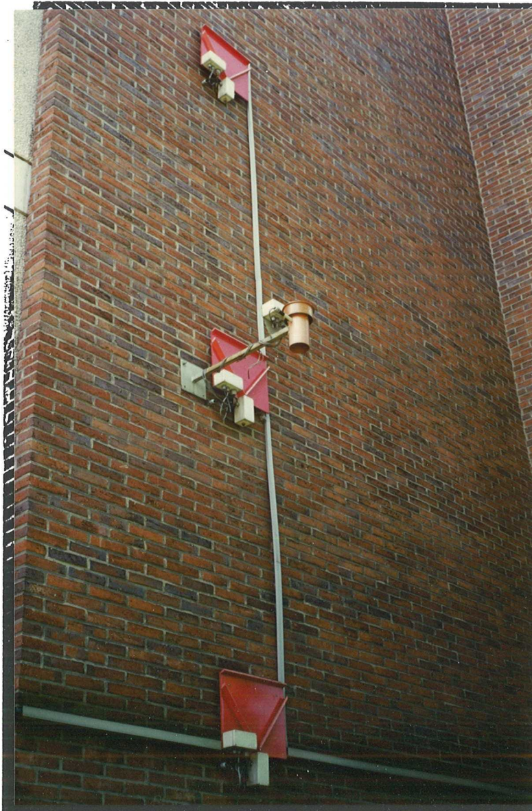
Bild 17: Anordnung der Meßeinrichtungen an der Fassade
