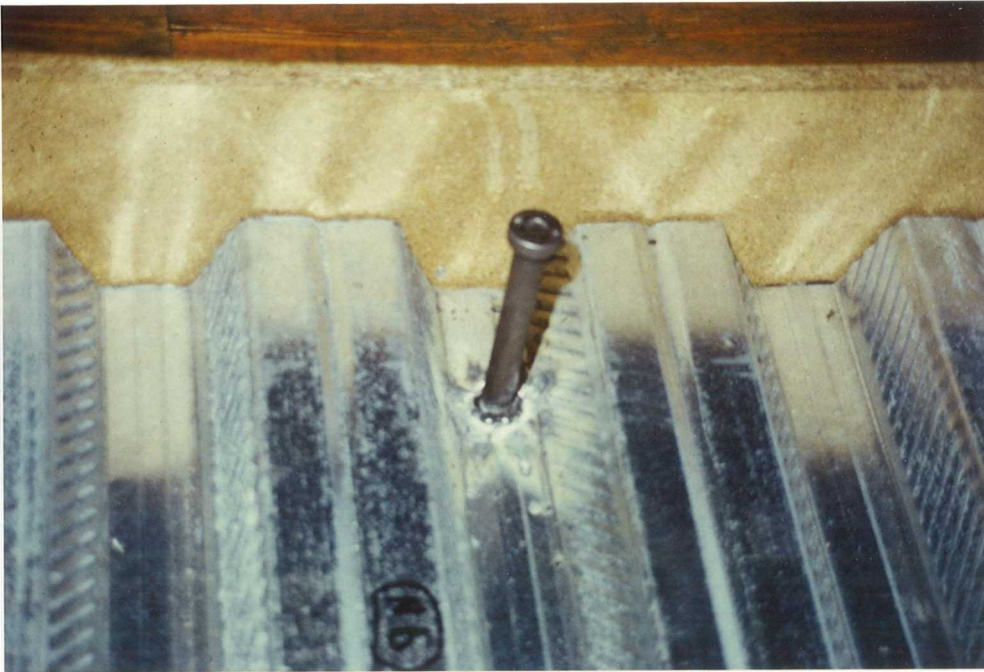
Bild A.2.1: Schalung mit durchgeschweißtem Kopfbolzendübel
