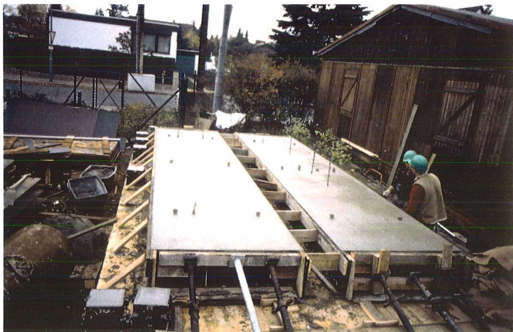
Bild 3.7: Betoniertes Trägerpaar
