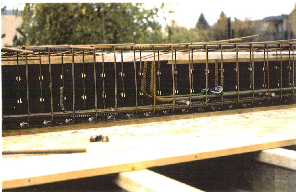
Bild 3.5: Ausschnitt der fertigen Bewehrung an der halbseitig stehenden Schalung
