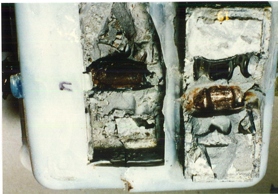
Bild 39: Detail der Reibstelle des Spanndrahts mit Bruchstelle und starker Korrosion
