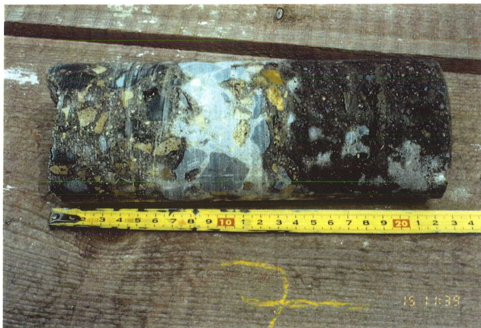
Bild 15: Bohrkern Nr. 7 nach Entnahme
