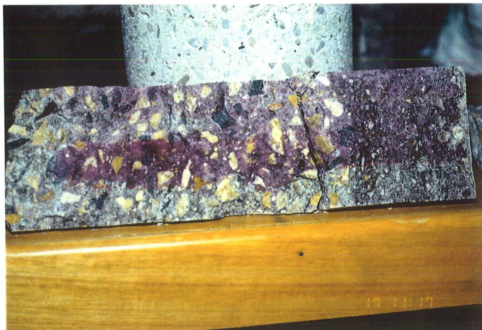
Bild 22: Bohrkern Nr. 6 Prüfung der Karbonatisierungstiefe durch streifenartiges Aufsprühen von Phenolphthalein auf die aufgespaltene Bruchfläche
