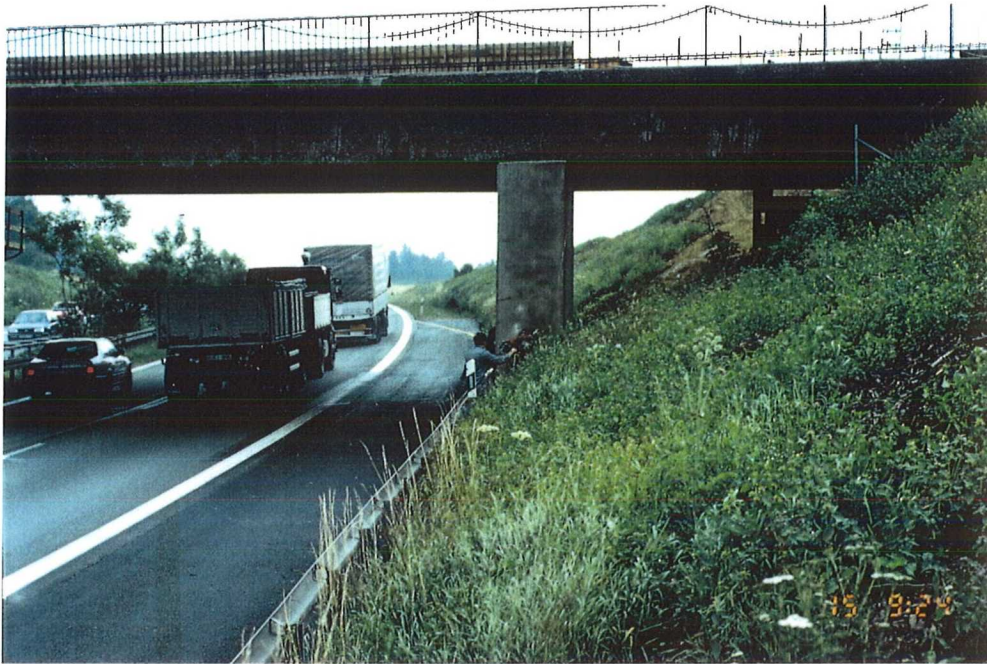
Bild 18: Brückensüdseite während der Kernbohrung am 15.07.1993
