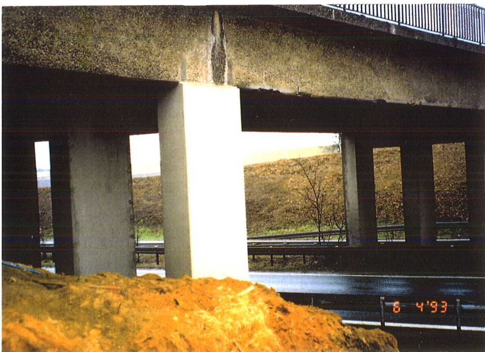
Bild 19: BW 276a Ansicht von Norden im April 1993
