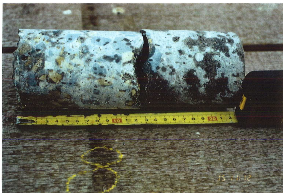
Bild 16: Bohrkern Nr. 8 nach Entnahme
