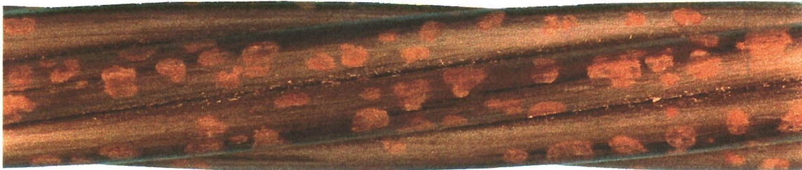
b) Oberfläche befreit von losen Korrosionsprodukten
