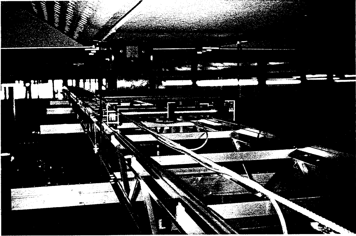
Abb. 9-13. Auf dem Gitterträgersystem läuft ein Schienenwagen, der über Zugseile angetrieben wird. Auf dem Schienenwagen werden die Geräte so positioniert, daß sie sich möglichst genau unterhalb der Spanngliedachse bewegen.
